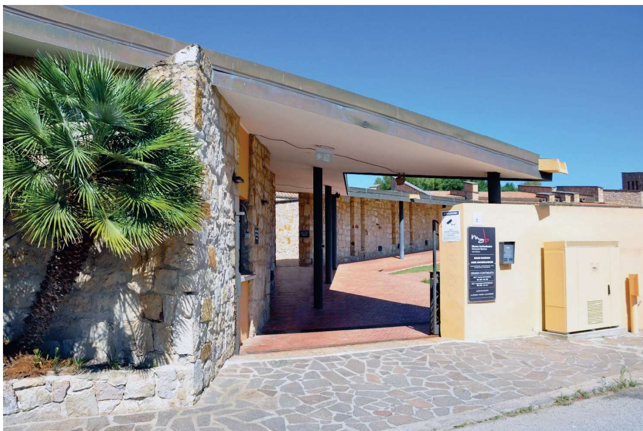
Figura 7- Ingresso al Museo, il marciapiede è ribassato ed in continuità con le rampe del museo.
