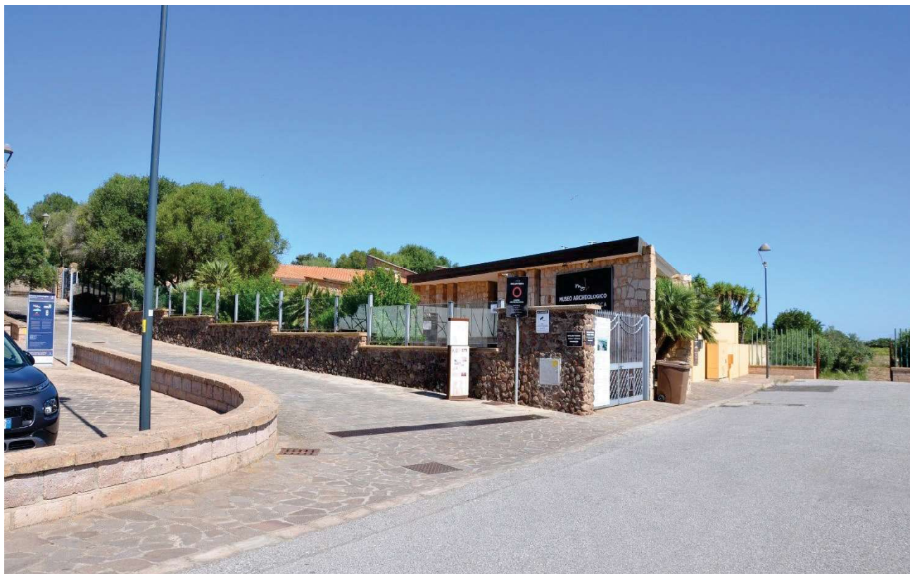
Figura 6 – Marciapiedi e sede stradali di larghezza adeguata e in continuità.
