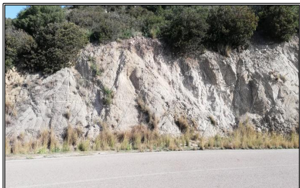
Foto n°7 - 8 – Fronte di scavo lungo la strada costiera interessata da fenomeni franosi e messa in sicurezza con reti in aderenza.
