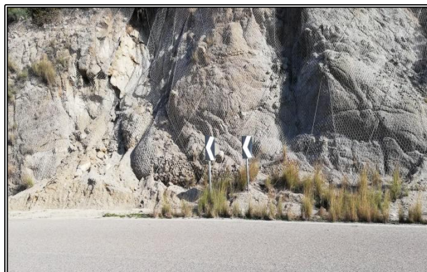
Foto n°7 - 8 – Fronte di scavo lungo la strada costiera interessata da fenomeni franosi e messa in sicurezza con reti in aderenza.
