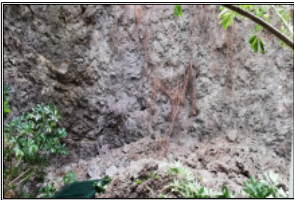
Foto n°3 - 4 – Fronte di scavo con materiale franato alla base e parete dello scavo interessata da fenomeni di instabilità e crolli.
