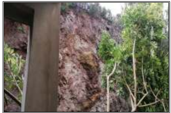
Foto n°3 - 4 – Fronte di scavo con materiale franato alla base e parete dello scavo interessata da fenomeni di instabilità e crolli.
