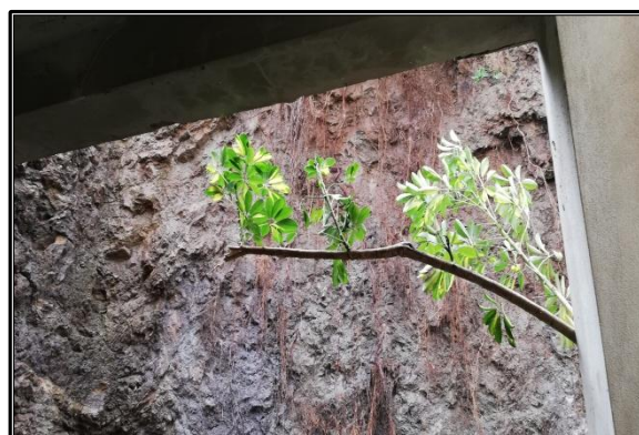
Foto n°5 - 6 – Fronte di scavo con materiale prossimo al distacco e parete dello scavo interessata dai fenomeni di instabilità e crolli in prossimità del pilastro dell'abitazione evacuata.
