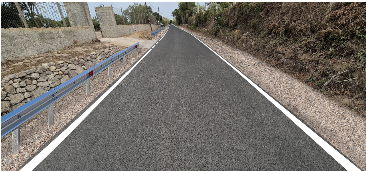
Vista 2 POST intervento con bitumature, sistemazione banchine, installazione barriere stradali e segnaletica orizzontale
