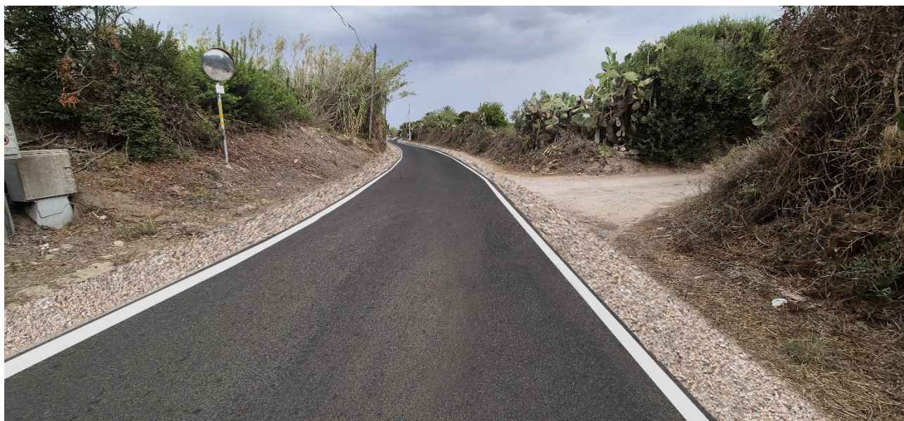
Vista 1 POST intervento con bitumature, sistemazione banchine e segnaletica orizzontale
