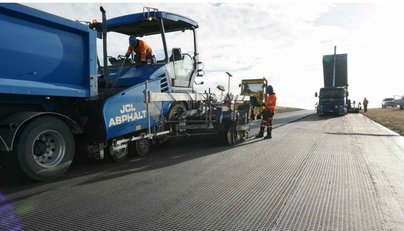
PARTICOLARE POSA GEOCOMPOSITO E SUCCESSIVA BITUMATURA
