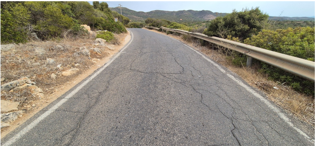
Vista ANTE intervento – Tratto di strada con presenza di barriera stradale laterale
