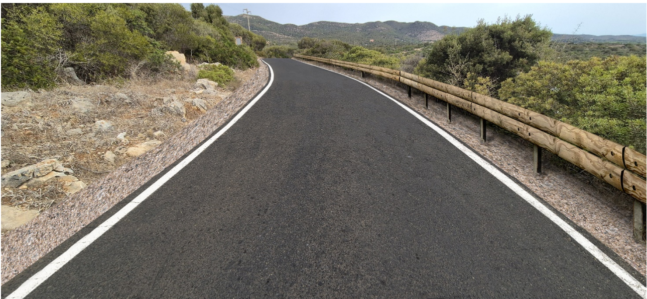
Vista POST intervento – Tratto di strada con presenza di barriera stradale laterale
