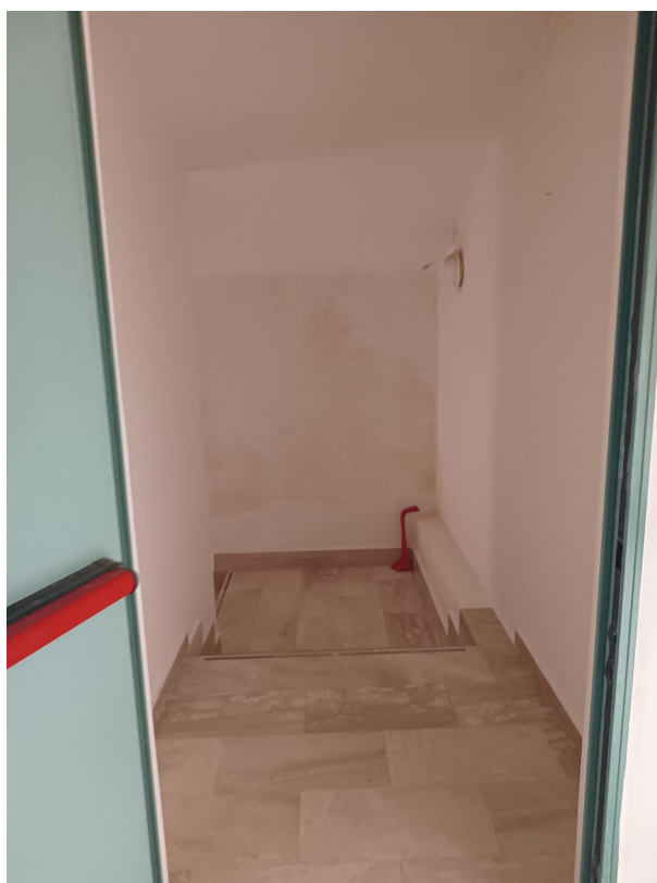
Immagine 12 – Vano Scala ante lavori
