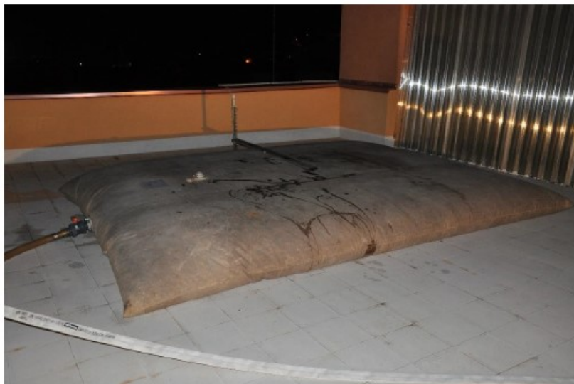
Fotografia 3 - Serbatoio a pieno carico all'estradosso del solaio di monitorare
