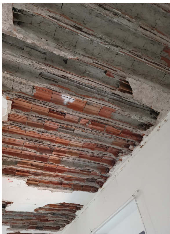
Immagine 5 – solaio piano primo – terrazza dopo la battitura manuale
