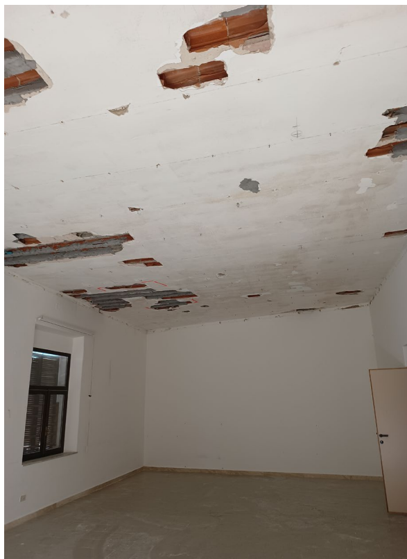
Immagine 4 – solaio piano primo – terrazza dopo lo smontaggio del controsoffitto
