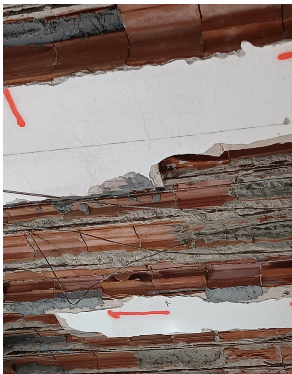
Immagine 7 – solaio piano primo – terrazza dopo la battitura manuale
