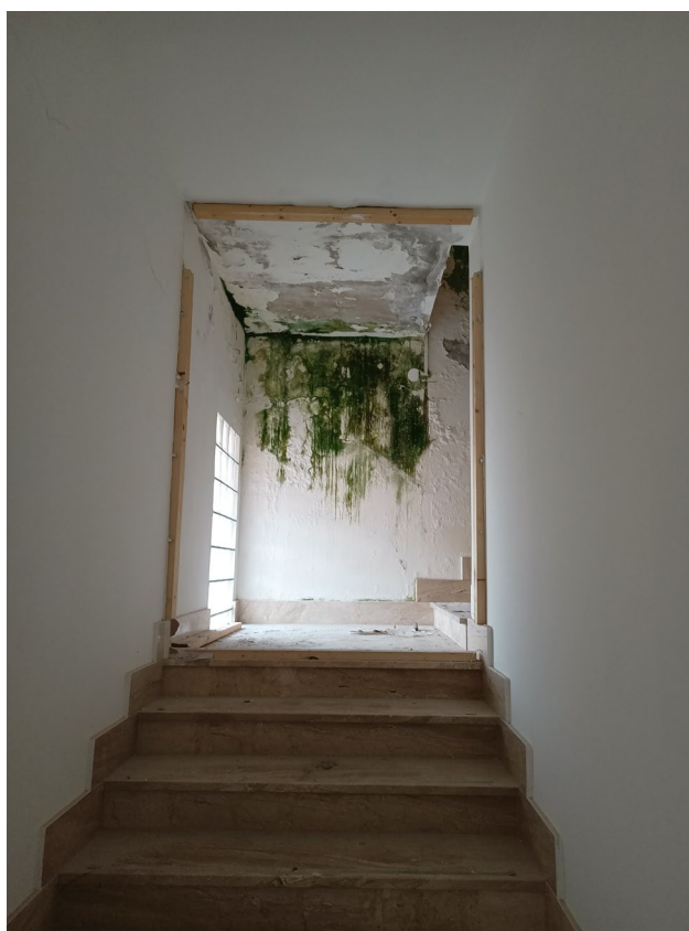
Immagine 14 – Vano Scala stato attuale
