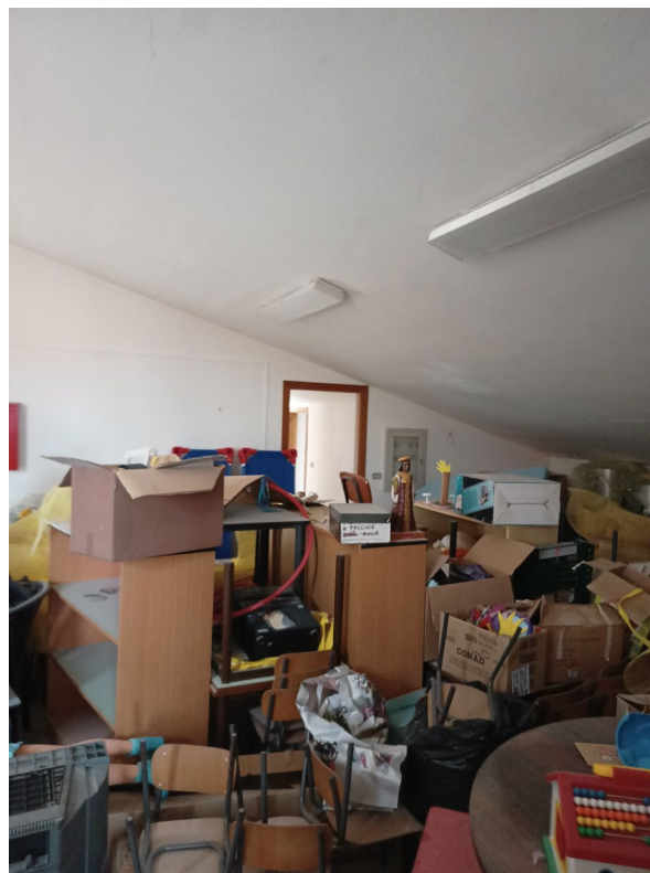
Immagine 9– solaio copertura ante lavori
