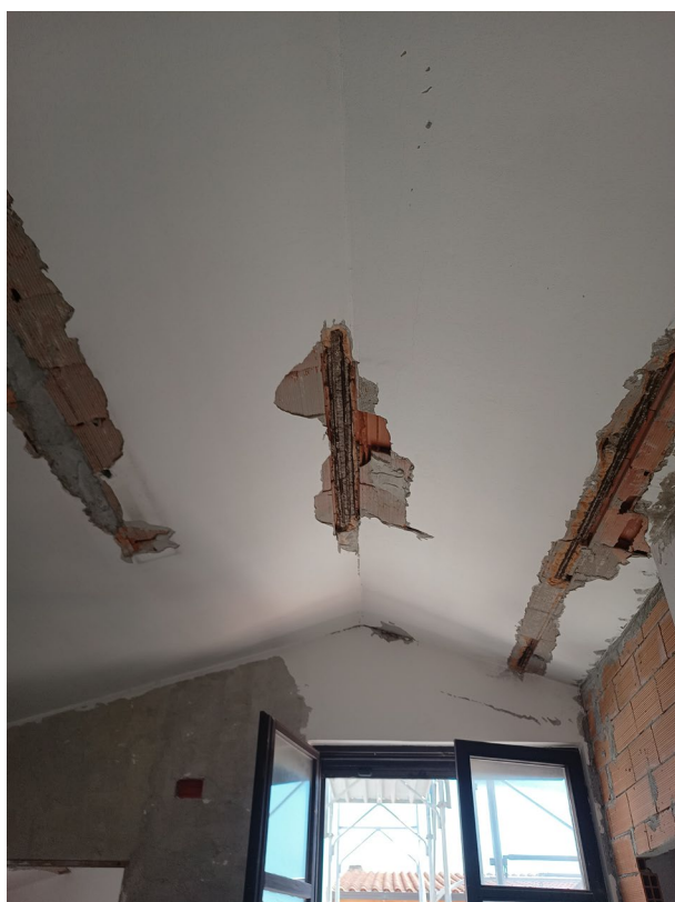
Immagine 11 – solaio copertura dopo la battitura manuale
