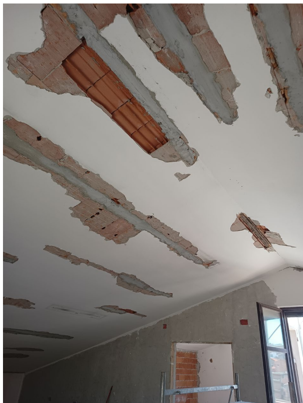
Immagine 10 – solaio copertura dopo la battitura manuale
