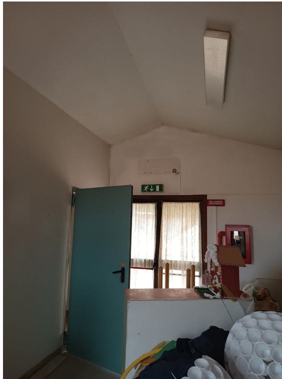
Immagine 8 – solaio copertura ante lavori
