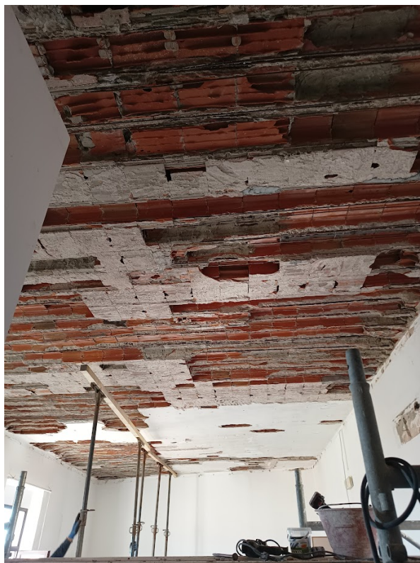
Immagine 6 – solaio piano primo – terrazza dopo la battitura manuale
