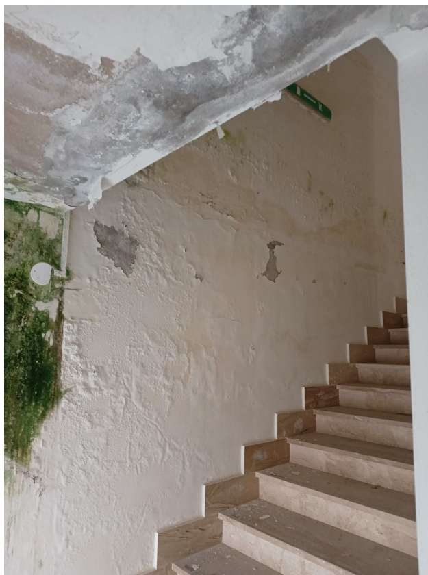
Immagine 15 – Vano Scala stato attuale
