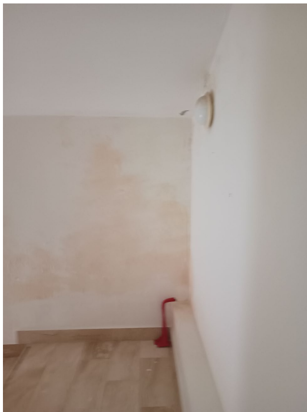
Immagine 13 – Vano Scala ante lavori
